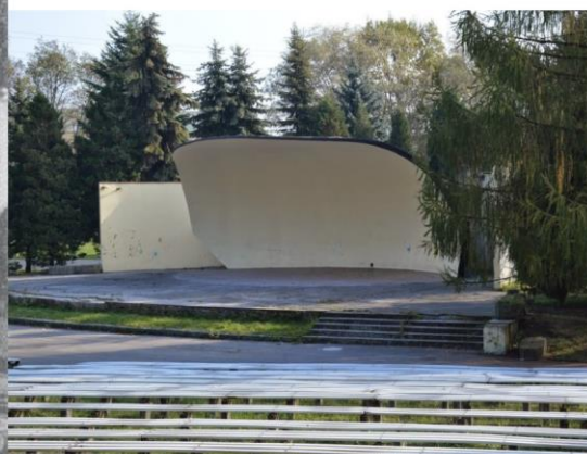
AMFITEATR OBECNIE DO ROZBIÓRKI
